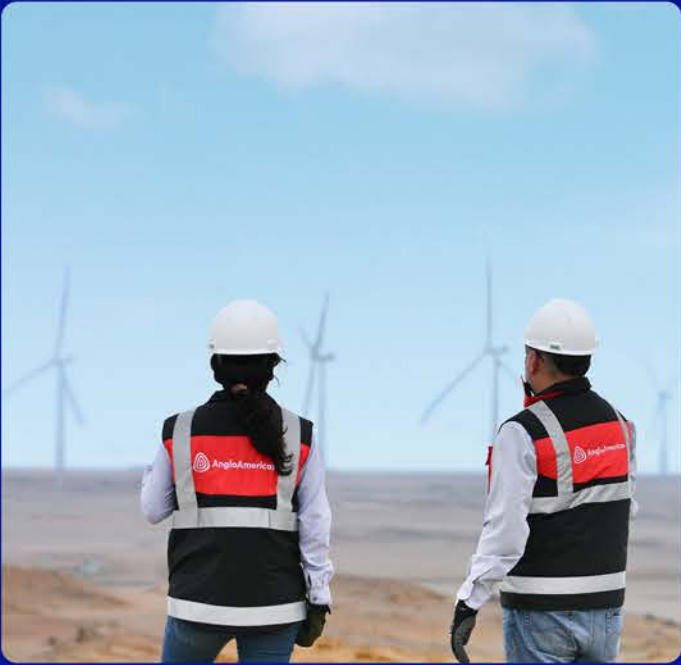
Inspección del mayor parque eólico de Perú en Punta Lomitas. El parque eólico garantiza que la mina de Quellaveco funcione con 100% de energía de origen renovable.
