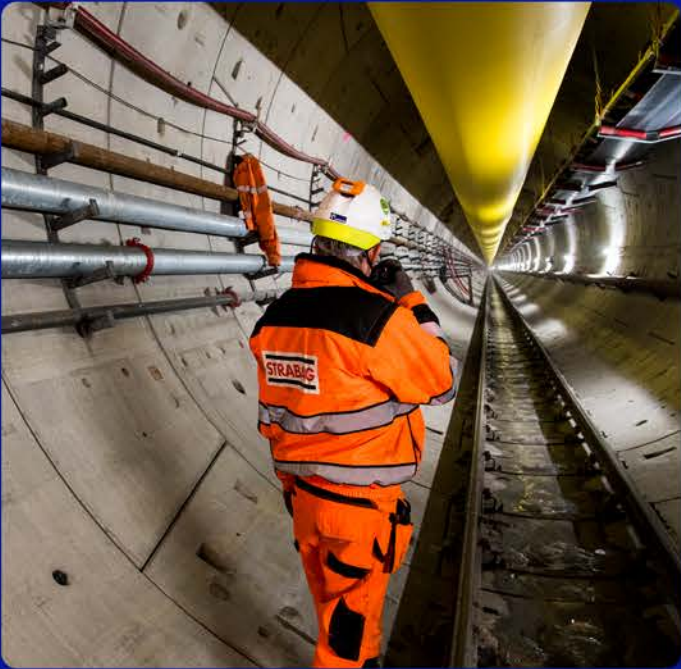
Avanza la construcción en el sistema de transporte de materiales que conectará el proyecto Woodsmith con las instalaciones del manejo de materiales y la infraestructura portuaria.
