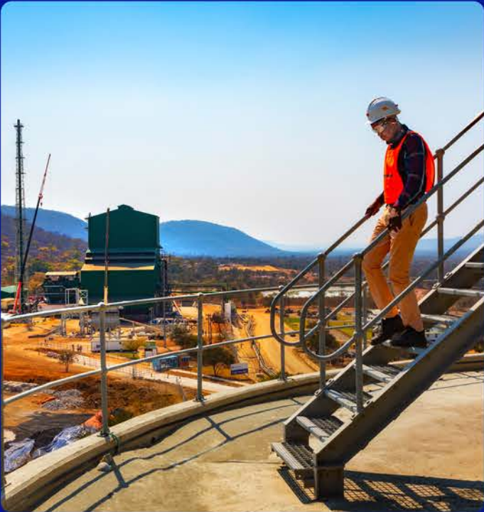
Supervisión del fundidor en la mina de PGM Unki, en Zimbabwe.
