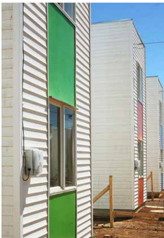
Proyecto de reconstrucción de casas post terremoto en Cocholegüe, Región del Bío Bío.
