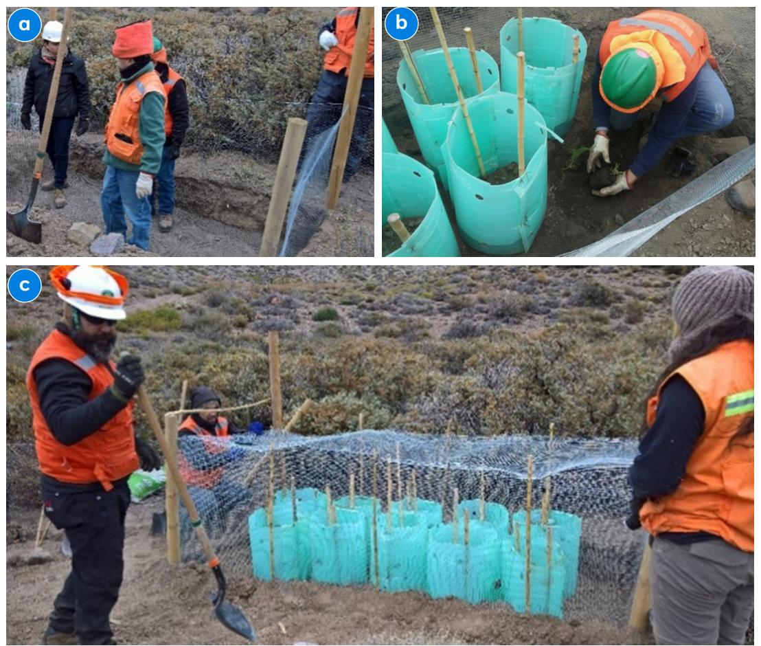
**Figura 14.** a) Excavación del núcleo e instalación de la malla al fondo. La sección de malla instalada al fondo sobresale hacia arriba 1 metro para facilidad de cierre perimetral; b) distribución de las plantas en las casillas e instalación del tree shelter para cada una; c) núcleo protegido en pleno nivelado y terminado.
